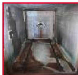
Links: filterhouder met gedeeltelijke corrosieaantasting Oorzaak: Zware roestvorming van de sterilisatiekamer door vlieg-/vervolgroestschade
